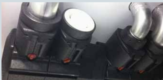
Zentrales schall- und wärmedämmtes Verteiler-Modul
